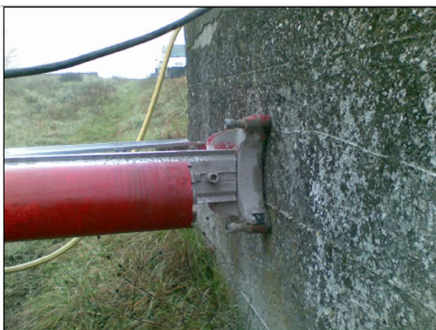
Installazione del trapano carotatore.
