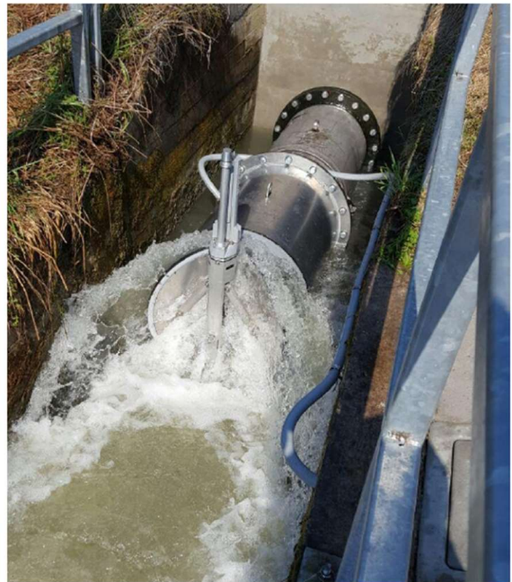
Figura 4: Macchina idraulica con valvola, in posizione di apertura intermedia.
