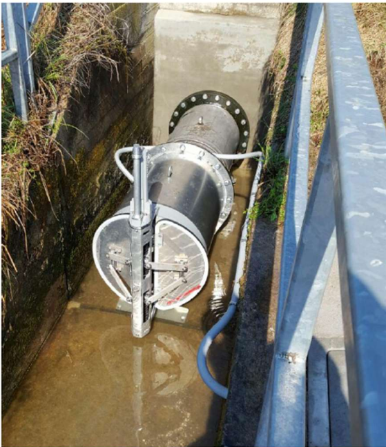
Figura 3: Macchina idraulica con valvola, in posizione chiusa.
