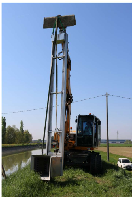
Figura 1: Vista complessiva della paratoia, con guide e box di misura, in fase d'installazione
